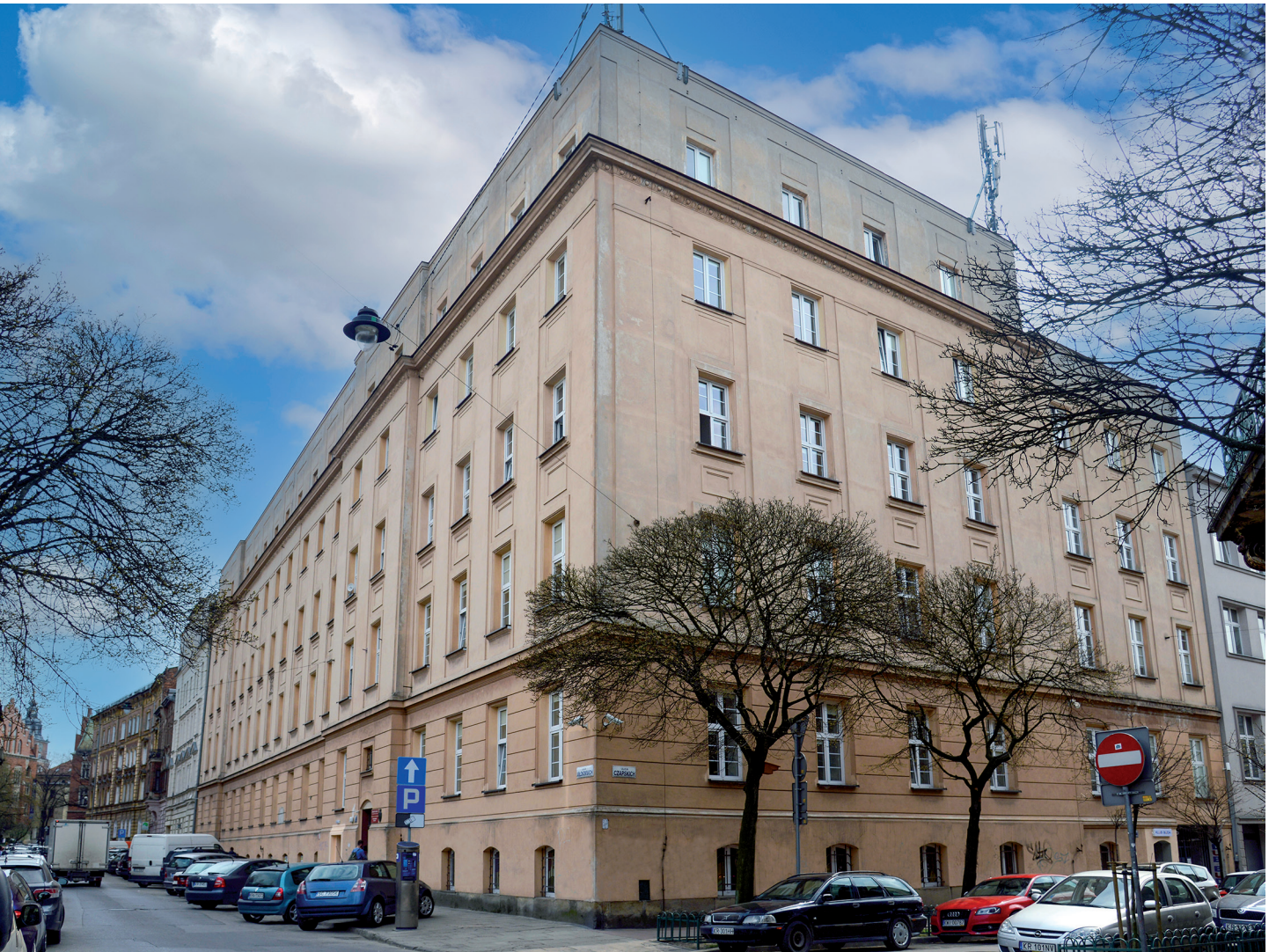
“Bratniak” dormitory. Photo: G. Wojcieszek
